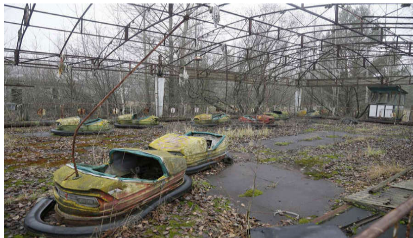
شکل ۸. آثار و پیامدهای حادثه انفجار چرنوبیل و آلودگی شدید منطقه
